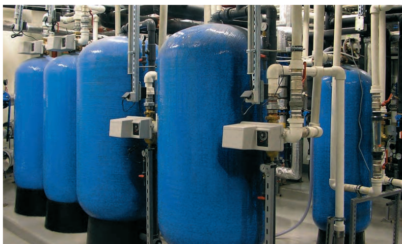
Гостиница «КРАСНЫЕ ХОЛМЫ» ***** Система осветления, умягчения и дехлорирования 20 м 3 /час
